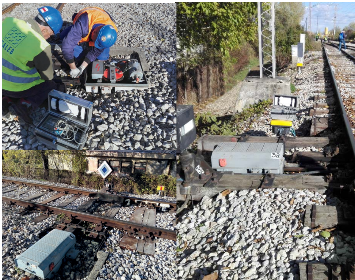
Ispitivanje elektropostavne sprave
