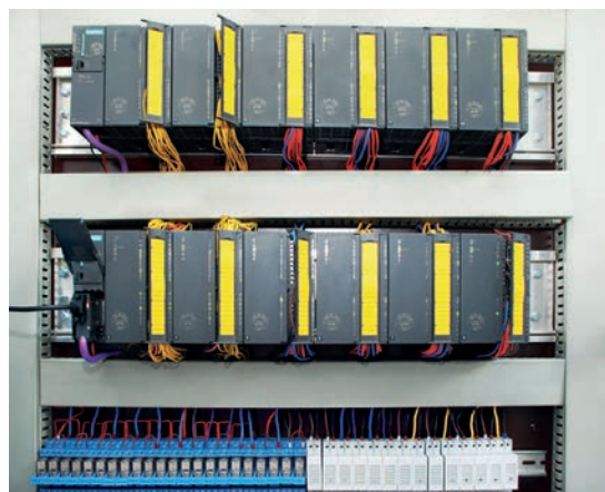
Elektronski uređaj putnog prelaza GFSU LC09
