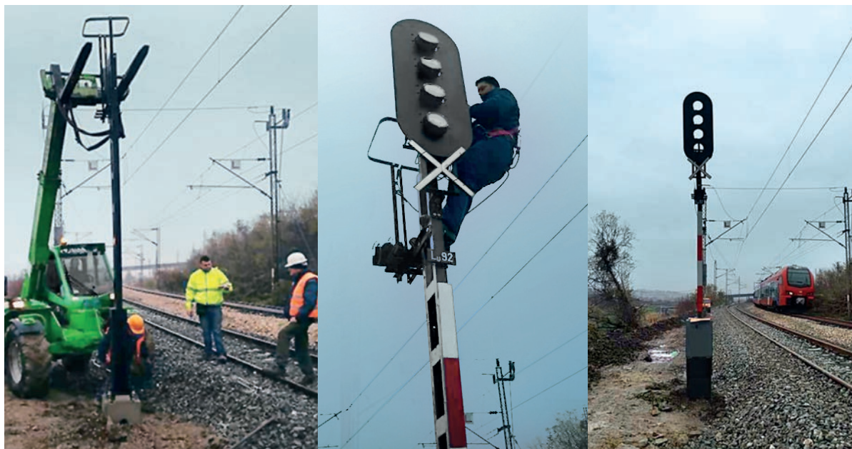
Montiranje stubnog signala sa 4 svetiljke
